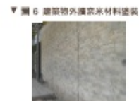
▼ 圖 6 建築外牆奈米材料塗裝
